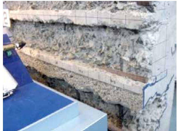
コンクリート構造物の劣化部分のみのはつり 鉄骨や鉄筋にダメージを与えない
